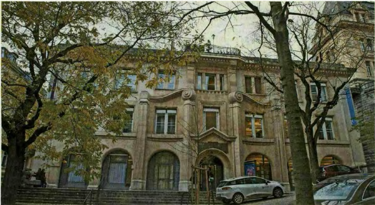
Le siège de la HEMU Vaud Valais Fribourg et du Conservatoire de Lausanne, réunis sous la même fondation, est situé à la rue de la Grotte, à Lausanne, dans un bâtiment propriété de la Ville. VANESSA CARDOSO
